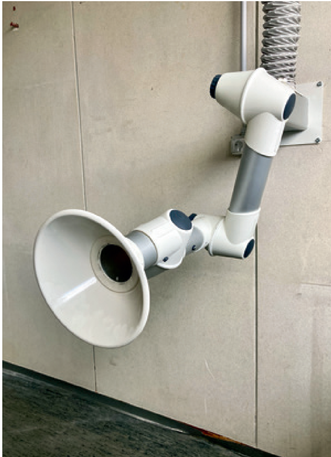
Einzelpunktabsaugung im Laborraum, 28.06.2023, 11:57 Uhr
